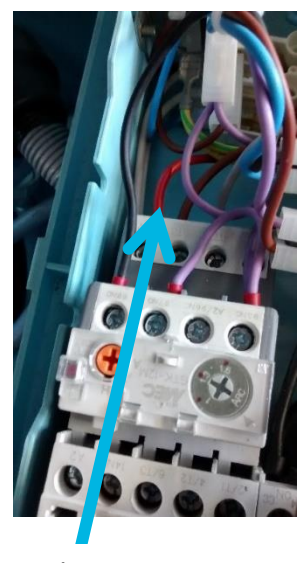
Unidades no modulares: desconectar cable rojo salida a contactor compresor
