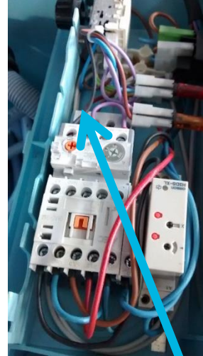
Unités non modulaires: Débranchez la prise de câble rouge au CONTACTEUR du compresseur
