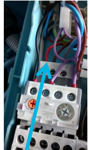
Unités non modulaires: Débranchez la prise de câble rouge au CONTACTEUR du compresseur
