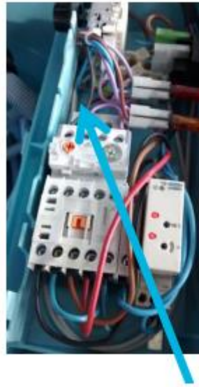
Unidades no modulares: desconectar cable rojo salida a contactor compresor
